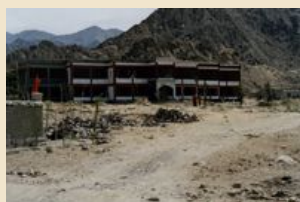
Aggregaat voor school in Leh, Ladakh India
